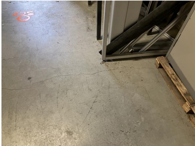
Fissures en dallage repérées au niveau de la future salle blanche
